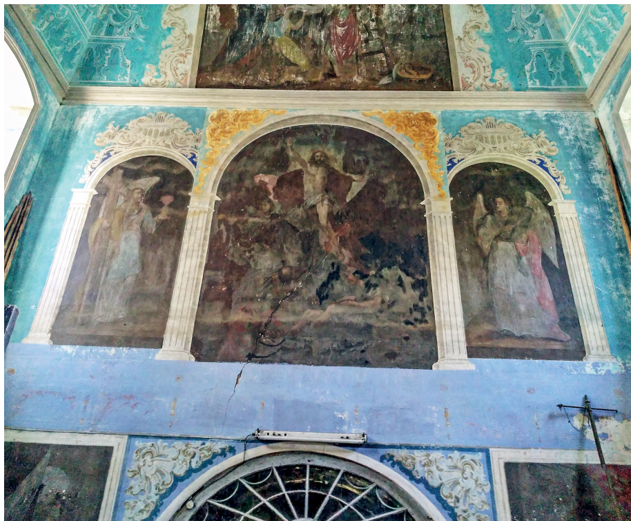
Фото 14. Западная стена четверика, 2020.
